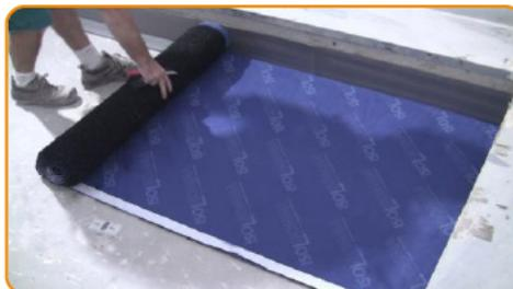
Legen Sie die Trittschalldämmung mit der Granulatseite nach unten auf den Boden.
