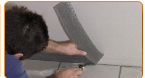
Wenn der Bodenbelag fertig verlegt ist, schneiden Sie die überstehenden Teile der Randstreifen weg.
