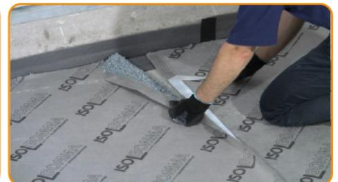
Drücken Sie den Überlappungsstreifen mit dem integrierten Kleband auf die untere Bahn.
