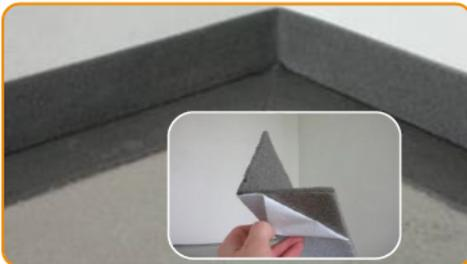
Isolieren Sie die Innenecken mit "Profile" Streifen, indem Sie die Randstreifen wie auf der Zeichnung dargestellt zuschneiden.
